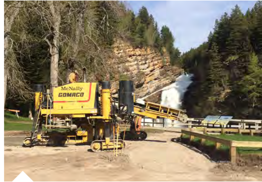
McNally legt betonnen trottoirs en asfaltwegen aan voor de Waterton Townsite.
